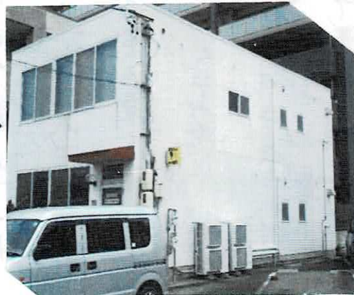
雨漏りした外壁にガルバリウム鋼板を覆いました
