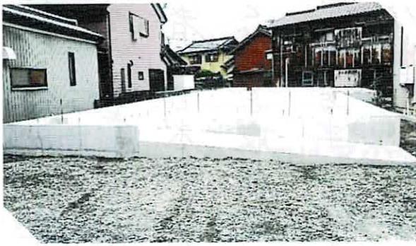
6月に基礎工事が完成
